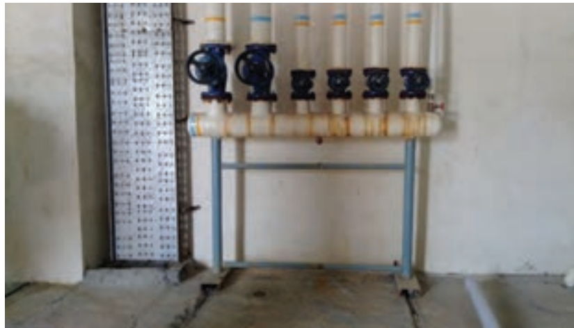
شکل ۲- نصب پایه کلکتور
