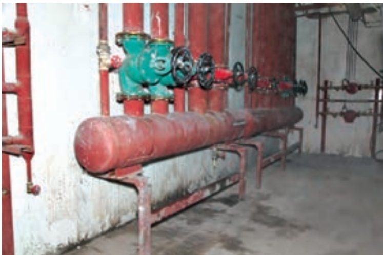
شکل ۱- نصب شیر تخلیه کلکتور
