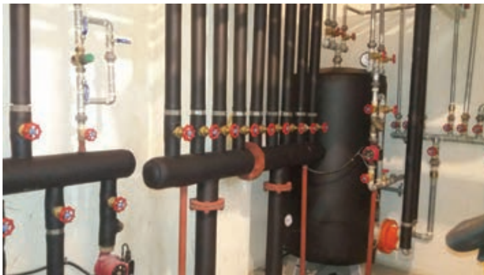
شکل ۲۵- عایق کاری در موتورخانه
