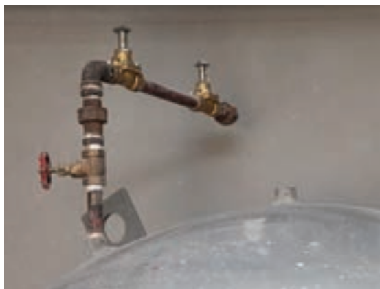
شکل ۲۳- اتصال لوله هواگیری مخزن
