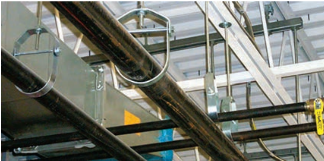
شکل ۱۲- نمونه‌ای از آویز سقفی
