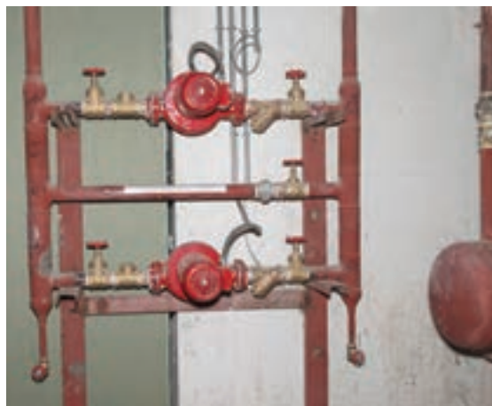
شکل ۲۴- اتصال شیر تخلیه
