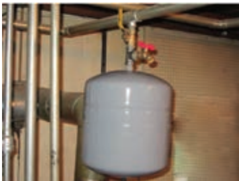
شکل ۲- مخزن انبساط بسته
