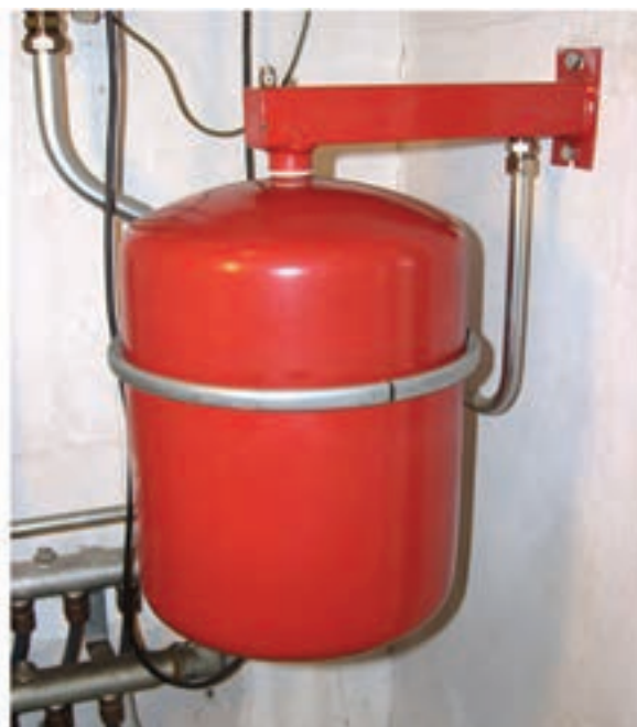
شکل ۱۶- استقرار مخزن انبساط بسته
