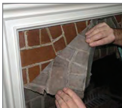
شکل ۲۱- دوده‌زدایی مکانیکی به روش برچسب پاک کننده
