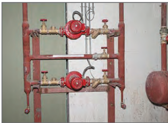
شکل ۱ - پمپ سیرکولاتور سیستم گرمایی
