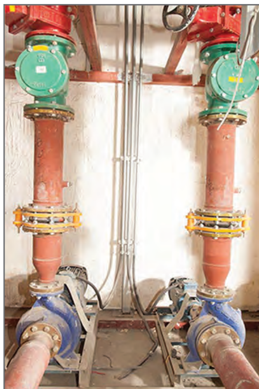
شکل ۳۲ - خط رانش پمپ زمینی
