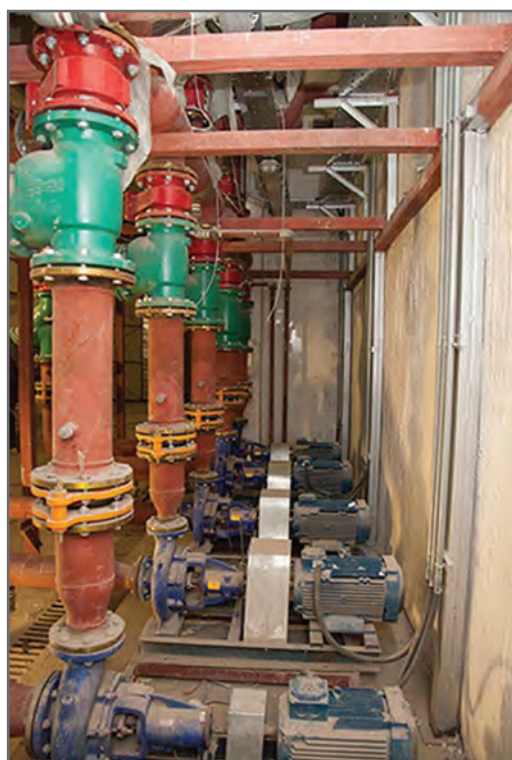
شکل ۳۲ - خط رانش پمپ زمینی
