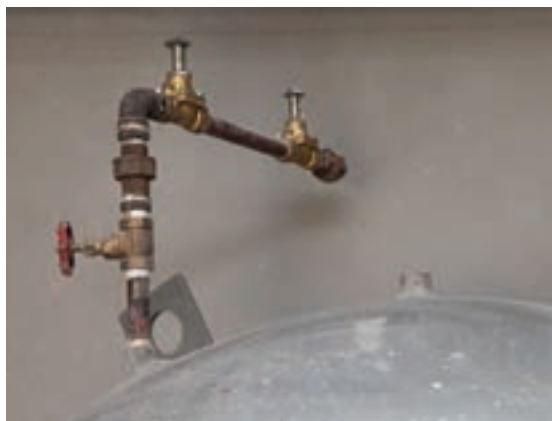
شکل ۲۳- اتصال لوله هواگیری مخزن
