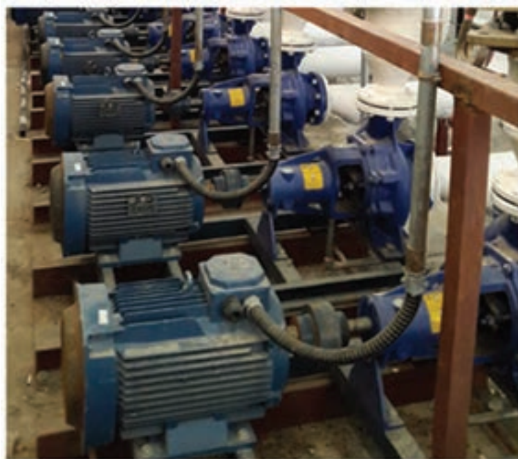
شکل ۲۴- اتصال موتورهای سه فاز
