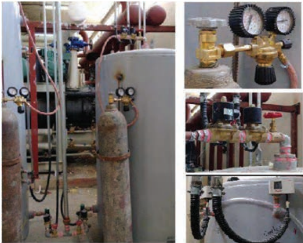
شکل ۲۳- مخزن انبساط بسته با متعلقات
