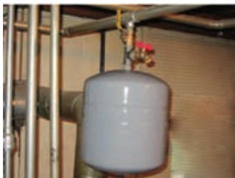
شکل ۲- مخزن انبساط بسته
