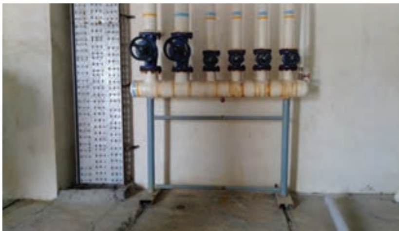
شکل ۲- نصب پایه کلکتور
