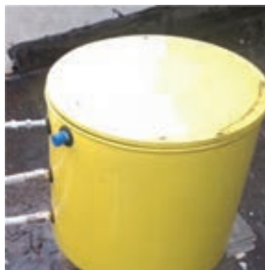
شکل ۳- مخزن انبساط باز با عایق
