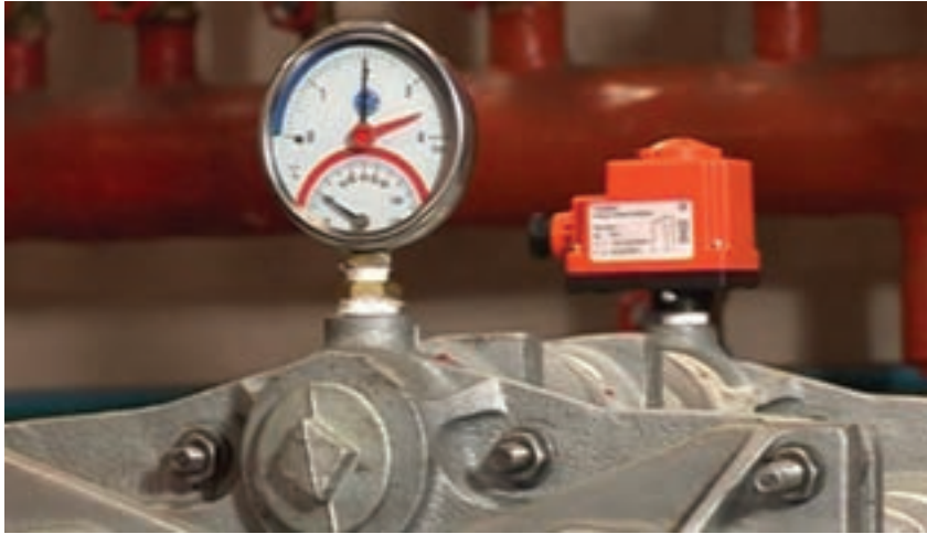
شکل ۲۱- نصب کنترل کننده و نشان دهنده دیگ
