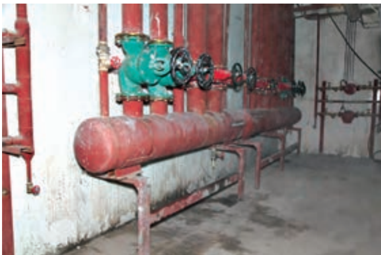
شکل ۱- نصب شیر تخلیه کلکتور
