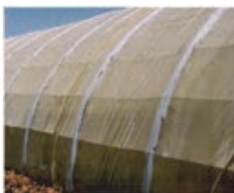
عایق‌کاری اجزا فولادی با رنگ سفید پلاستیکی
