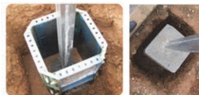
فونداسیون سازه گلخانه
