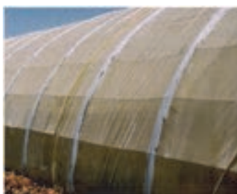
عایق‌کاری اجزا فولادی با رنگ سفید پلاستیکی
