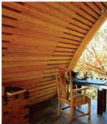
شکل ۱۲-۲- در سقف‌هایی که به زمین می‌رسند باید به سرگیر شدن قسمت‌های نزدیک زمین توجه داشت.
