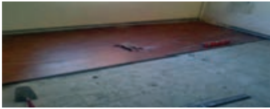
شکل ۲۸-۴- اجرای کف پوش لمینت
