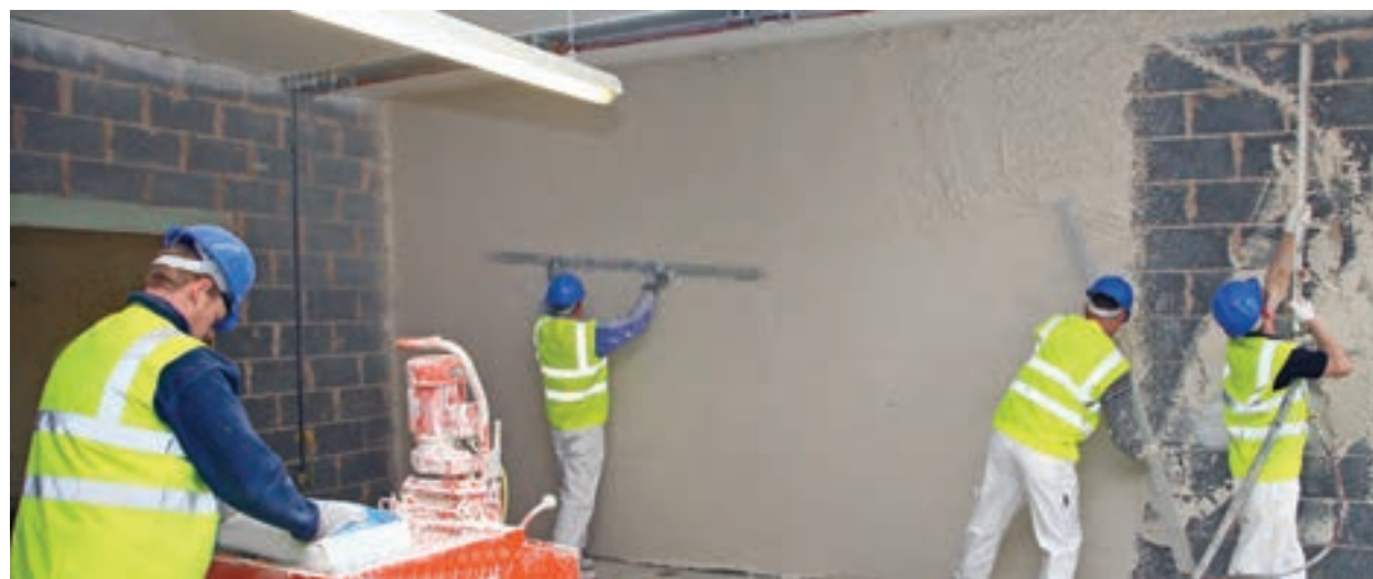
شکل ۱۷-۴- اندود گچ سفیدکاری روی دیوارهای داخلی
