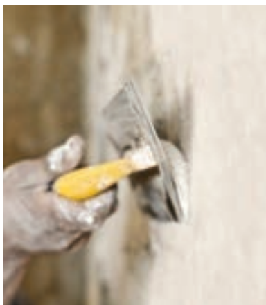
شکل ۱۶-۴- جزئیات نحوه مالکشی و شمشه‌گیری اندود گچی دیوار
