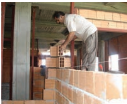
شکل ۱-۴- ریسمان کشی جهت اجرای مستقیم دیوار
