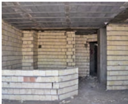
شکل ۴-۴- تیغه چینی داخلی با بلوک سفالی
