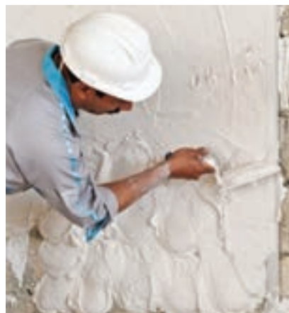
شکل ۱۶-۴- جزئیات نحوه مالکشی و شمشه‌گیری اندود گچی دیوار
