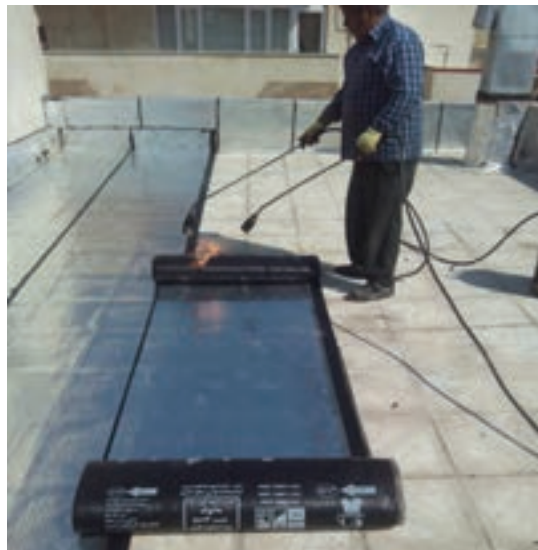
شکل ۱۲-۴- اجرای ایزولاسیون پیش ساخته بر روی کف بام
