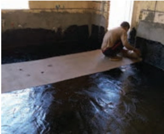
شکل ۱۱-۴- اجرای قیرگونی کف فضای داخلی
