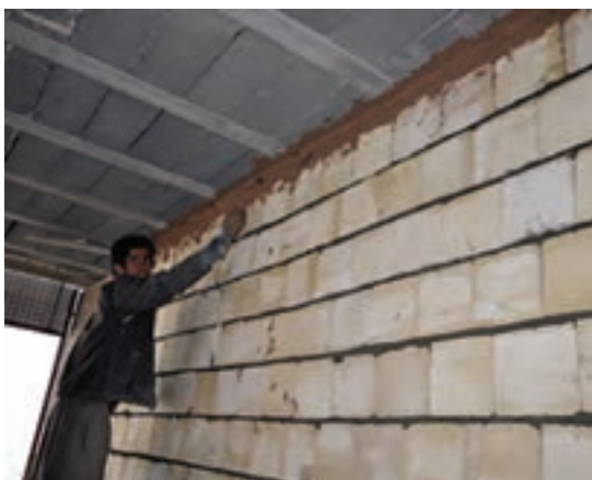
شکل ۲-۴- اجرای دیوار چینی با بلوک سفالی
