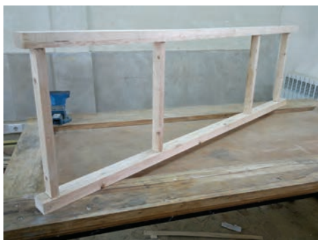
شکل ۵۲- اتصال موقت قطعات پاراوان
