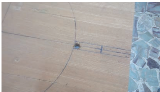
شکل ۵۸- سوراخ کاری برای قرار گرفتن تیغه
