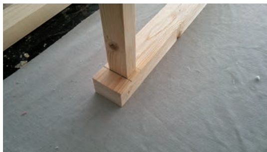
شکل ۴۷- استقرار قید افقی بر روی قید طولی
