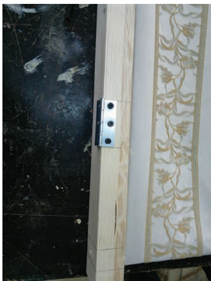
شکل ۷۲- محکم کردن برگه اول لولا با ۳ پیچ
