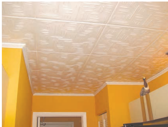
شکل ۳- اجرای سقف کاذب با فوم
