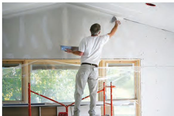
شکل ۱۸- پرداخت درز بین دیوار و سقف کاذب
