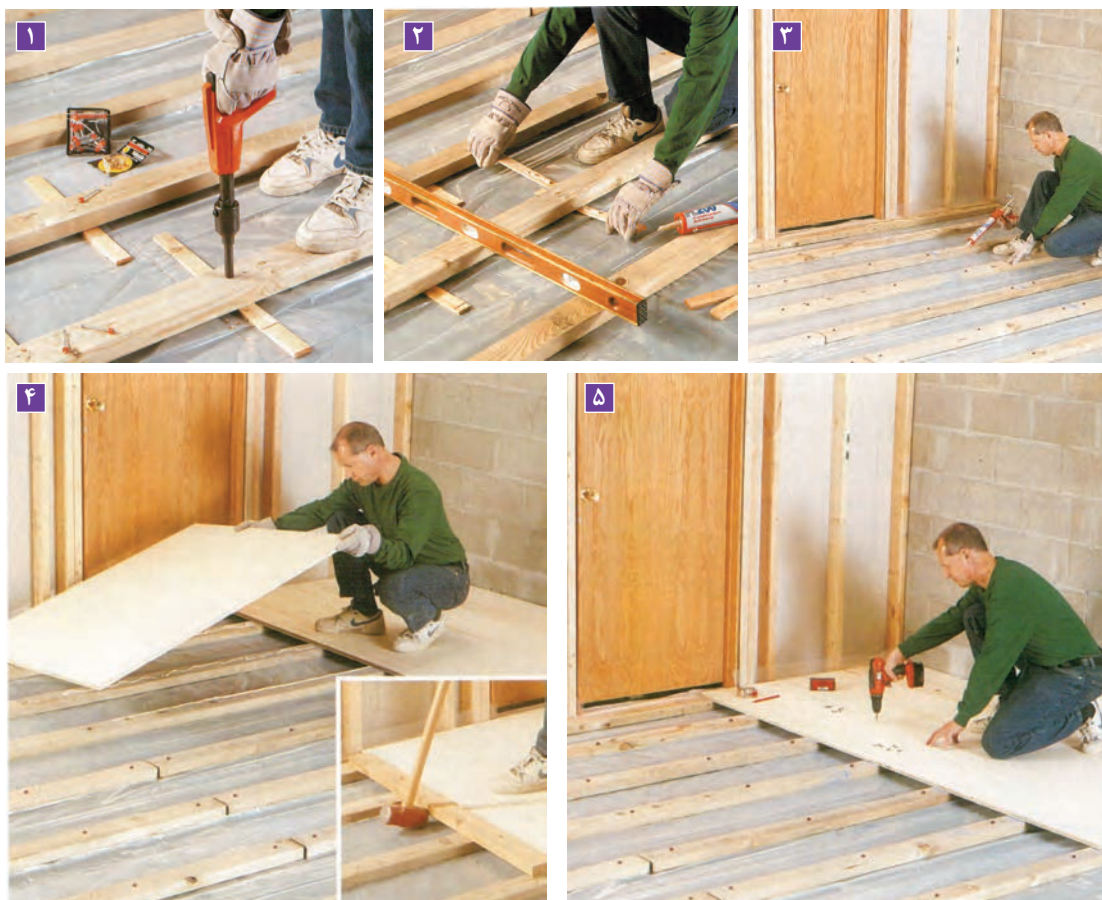
شکل ۴- مراحل نصب کف با تخته چوبی
