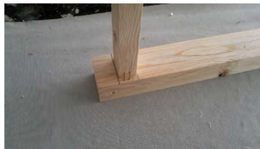
شکل ۴۹- زدن دو منگنه روی قید اول
