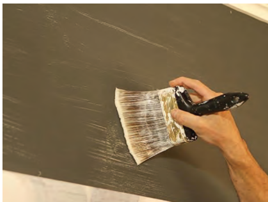
شکل ۸۴- چسب زدن دیوار
