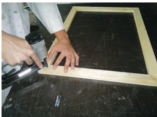
شکل ۲۸-منگنه زدن پشت قاب
