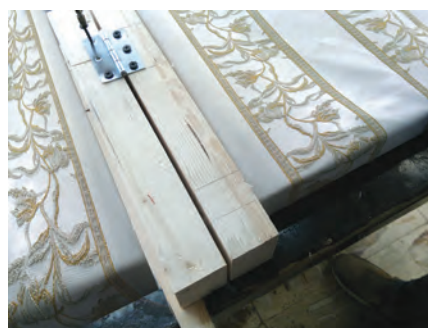
شکل ۷۴- بستن پیچ دوم برگه دوم لولا
