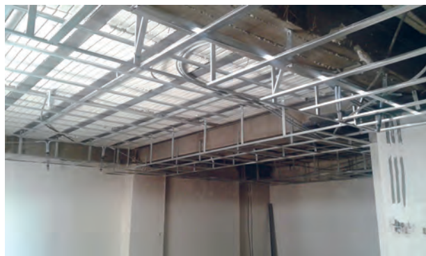
شکل ۱۶- بررسی تأسیسات و محل عبور سیم برق
