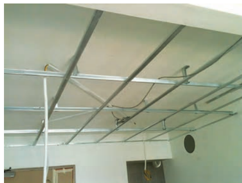
شکل ۱۶- بررسی تأسیسات و محل عبور سیم برق
