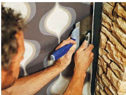
شکل ۸۵- برش اضافه پارچه روی دیوار
