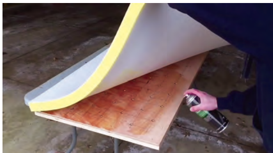
شکل ۵۲- چسب زدن روی تخته
