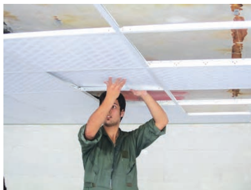
شکل ۱۷- نصب و تنظیم پنل در شبکه فلزی
