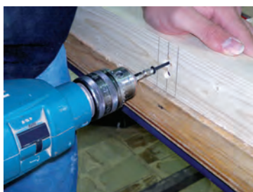
شکل ۵۸- بستن پیچ در حالت افقی
