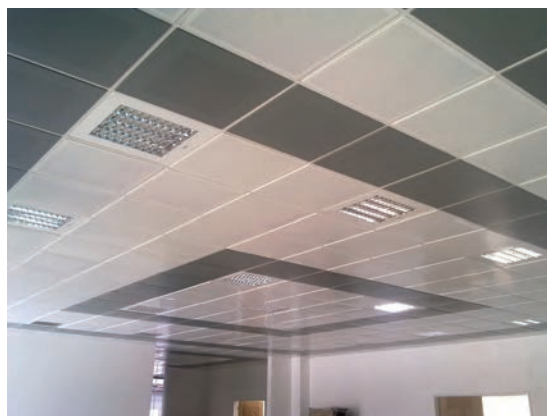
شکل ۱- اجرای سقف کاذب با مواد صداگیر
