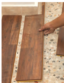
شکل ۹۰ و ۹۱ - قفل کردن قطعات لمینت به یکدیگر
