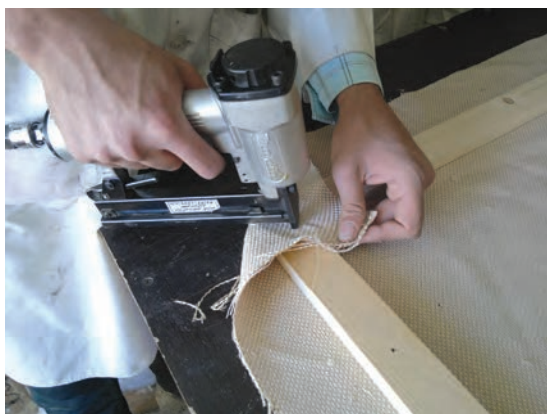
شکل ۳۲- منگنه زدن گوشه قاب
