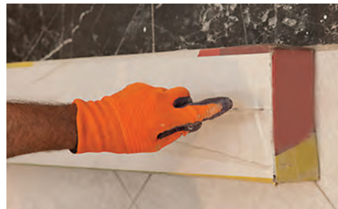
شکل ۲۸ و ۲۹- نحوه قرار دادن درست جعبه های لمینت
