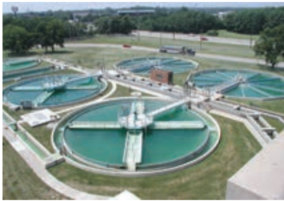
تصفیه آب در تصفیه خانه
