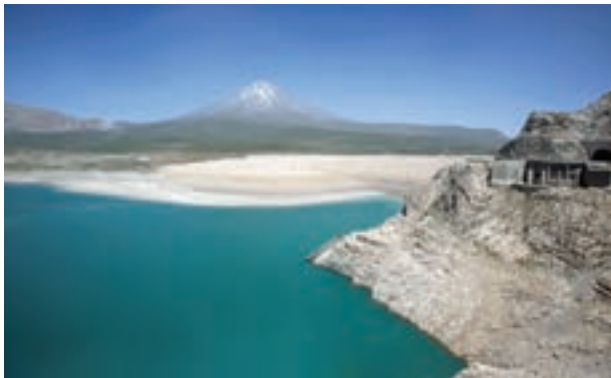
شکل ۶- سد لار در تهران، در مکان مناسبی احداث نشده است.
