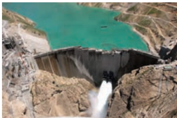
شکل ۴- سد کارون (۴) - خوزستان
