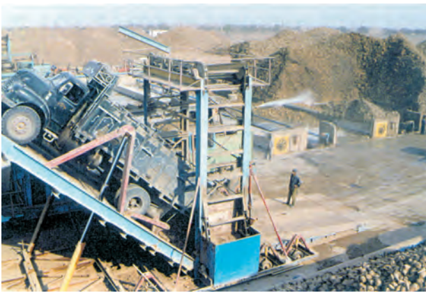
شکل ۱-۶- تخلیه چغندر در ابتدای خط کارخانه
