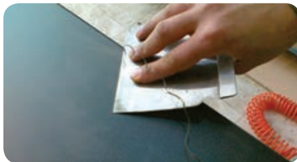
شکل ۲۵-۴ - نحوه برطرف کردن اضافه نوار با لیسسه
