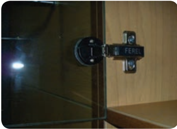
شکل ۱۴۳-۵- نصب لولای شیشه‌ای گازی برای در شیشه‌ای ویتربین
