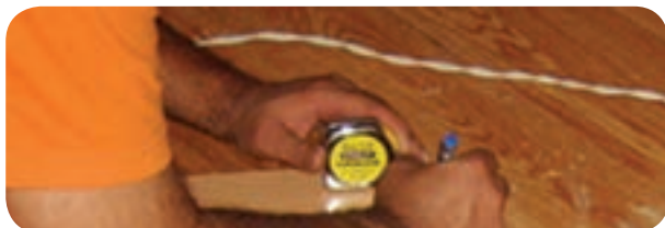
شکل ۵-۱۲۳- علامت‌گذاری و تعیین محل سوراخ‌ها
