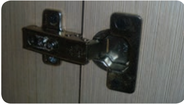
شکل ۵-۱۶۳- نصب لولای گازی فنردار به در کمد
