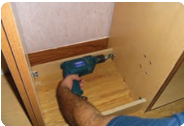
شکل ۱۸۰-۵- نصب پاسنگ‌ها
