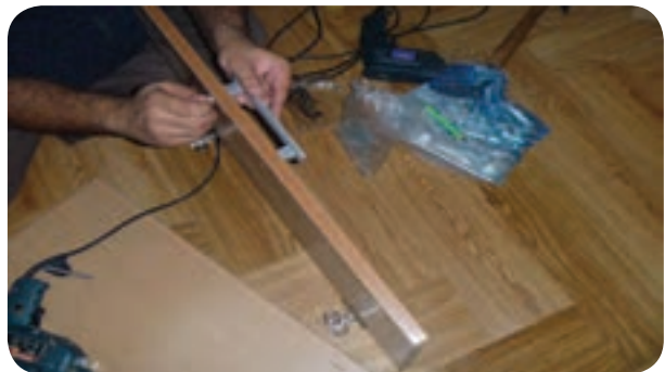
شکل ۱۵۹-۵- نصب دستگیره در کمد
