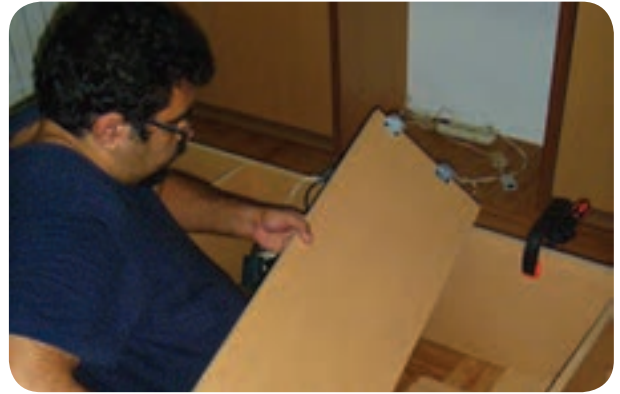
شکل ۵-۱۶۱- نصب طبقات به وسیله گونیاها فلزی
