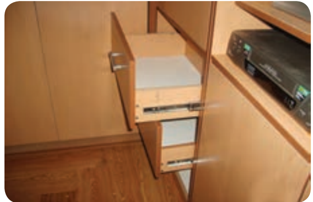
شکل ۱۷۷-۵- نصب کشویی تلسکوپی سه ريله برای کشو
