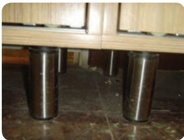
شکل ۵-۸ پایه‌های قابل تنظیم
