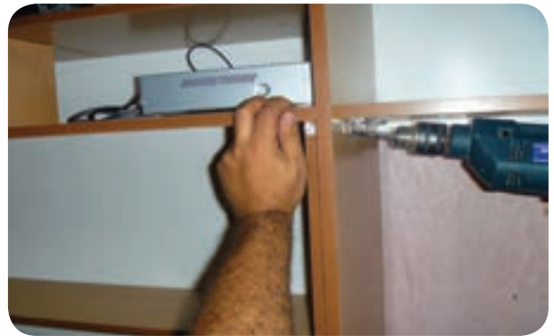
شکل ۱۴۲-۵- استفاده از اتصال گونبای فلزی در نصب طبقات
