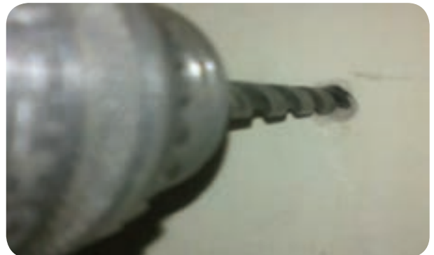
شکل ۶-۶ - سوراخکاری دیوار با مته الماسه مناسب
