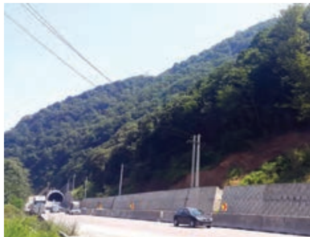
نصب حفاظ بتونی - جاده قائم‌شهر
