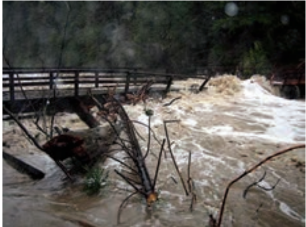
مسدود شدن دهانه پل با تنه و شاخ و برگ درختان موجب سرریز شدن سیل و تخریب پل می شود.
