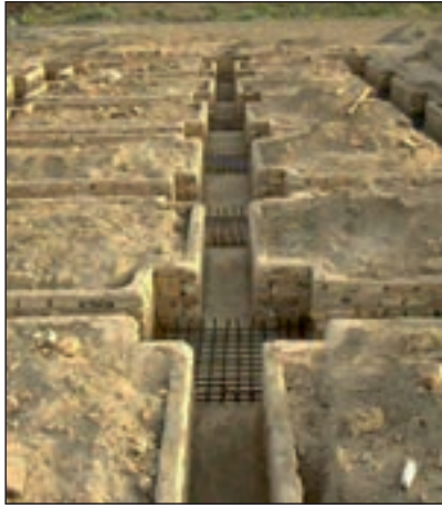
شکل ۴۸-۱ آرماتورگذاری پی تکی کلاف بندی شده
