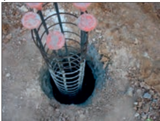
شکل ۱-۷۳ پی چاهی در حال اجرا
