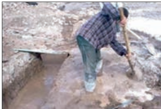
شکل ۱-۳۱ اجرای شفته آهک در فونداسیون
