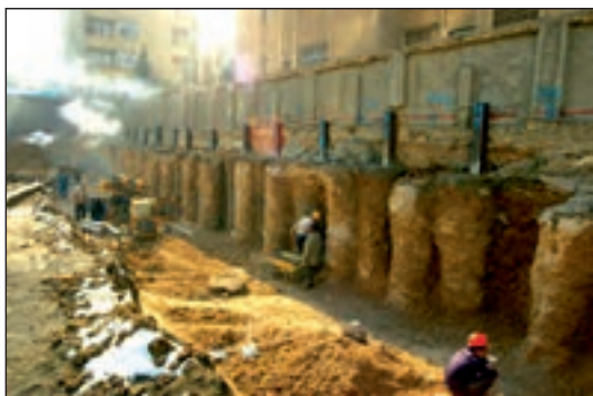
شکل ۸۸-۱ مهاربندی با پشت بند خاکی ستونی
