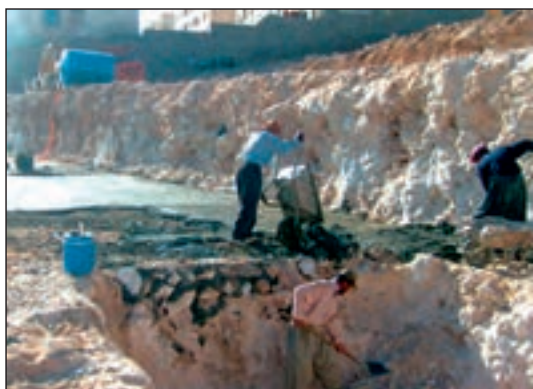
شکل ۸۷-۱ گودبرداری دستی (با بیل و کلنگ)
