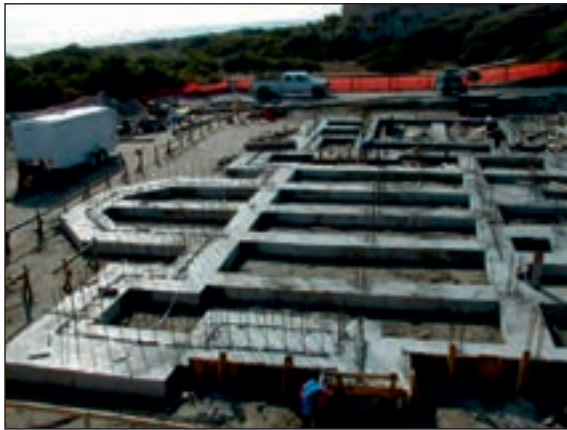
شکل ۱-۵۶ پی بتن مسلح نواری شبکه ای زیرستون
