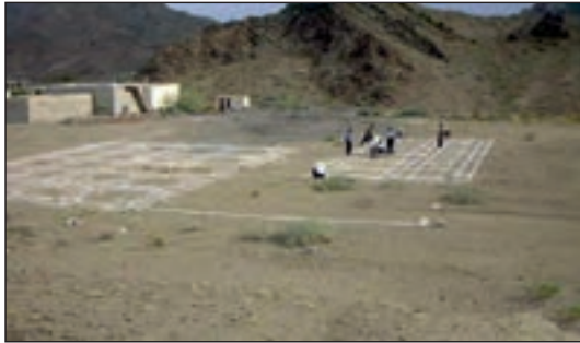
شکل ۸۳-۱ پیاده کردن نقشه روی زمین
