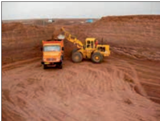
شکل ۸۵-۱ گودبرداری با لودر در زمین نامحدود
