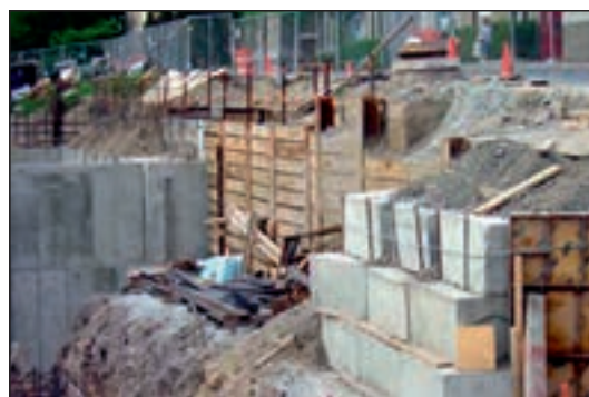
شکل ۹۱-۱ مهاربندی با دیوار مانع چوبی
