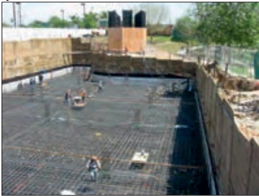
شکل ۱-۶۲ پی بتن مسلح یکپارچه (رادیه ژنرال)
