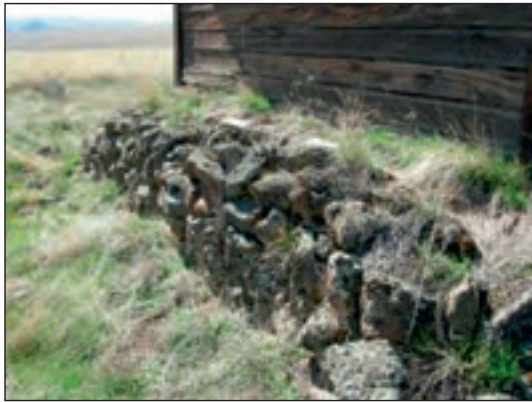
شکل ۱-۳۲ پی سنگی با سنگ لاشه
