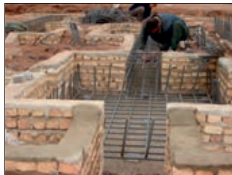
شکل ۱-۸۲ قالب‌بندی آجری در اطراف پی
