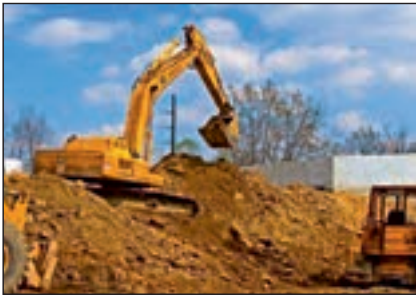
شکل ۱-۱۳- کندن زمین با وسایل مکانیکی
