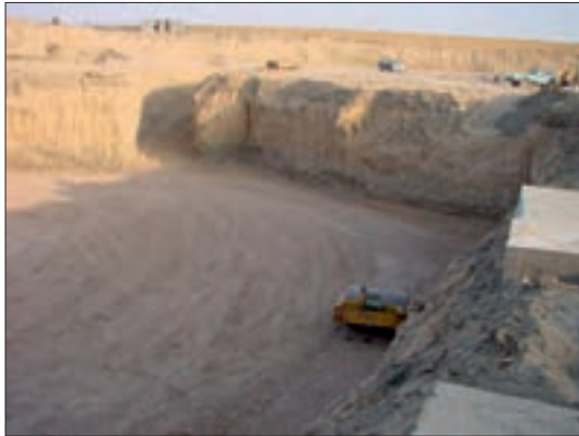
شکل ۸۴-۱ زمین گودبرداری شده
