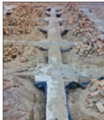
شکل ۷۳-۲ پی و شناژ بعد از بتن ریزی
