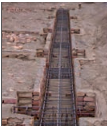
شکل ۷۲-۲ پی و شناژ قبل از بتن ریزی
