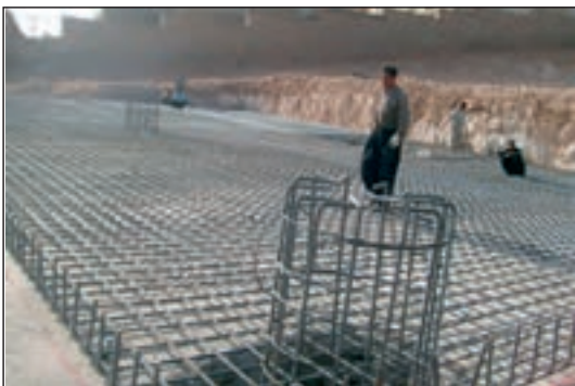
شکل ۱۵۲-۲ آرماتورگذاری پی صفحه‌ای با ستون‌های بتنی
