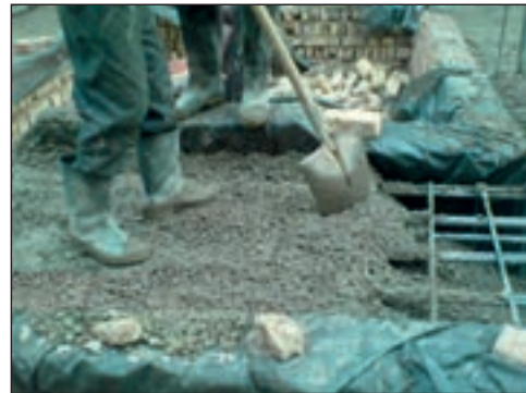
شکل ۲-۱۴۵ مرحله ی بتن ریزی داخل پی
