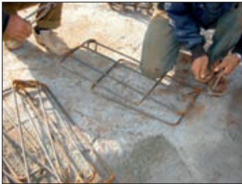
شکل ۲-۱۴۰ خم آرماتور و ساخت خاموت
