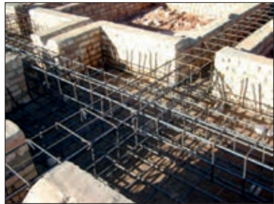
شکل ۷۱-۲ عبور میلگردهای شناژ در پی
