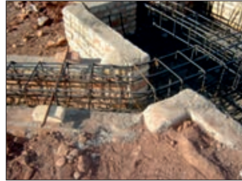
شکل ۲-۱۴۳ آرماتورهای شناژ و پی
