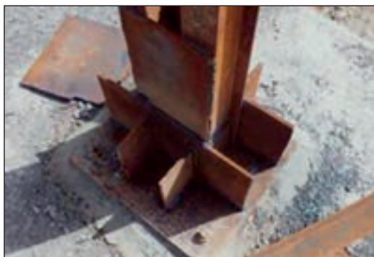
شکل ۱۶۸-۲ اتصال گیردار
