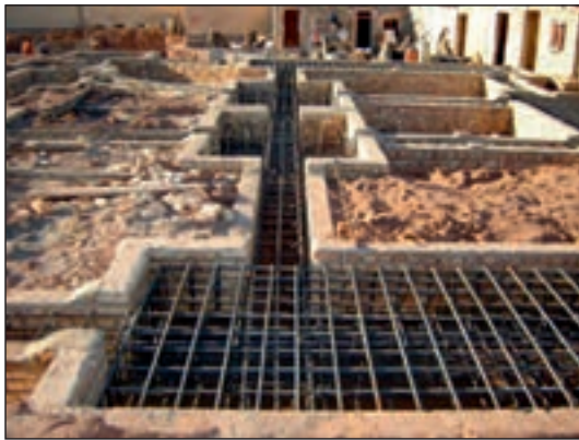
شکل ۷۰-۲ میلگردگذاری در پی کلاف بندی
