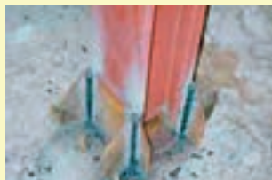
اتصال مناسب و جوش صحیح
