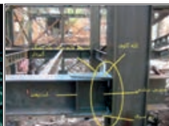
اتصال تیر به ستون به صورت ورق تقویت کننده
