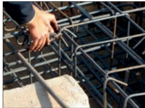
شکل ۲-۱۴۱ بستن خاموت دورآرماتور اصلی شناژ
