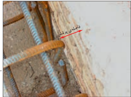
شکل ۱۲۶-۲ فاصله‌ی پوشش و قلاب سر میل‌گردها
