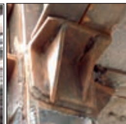
اتصال تیر به ستون به صورت لچکی
