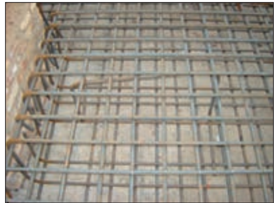
شکل ۱۴۷-۲ پی نواری و آرماتورگذاری آن
