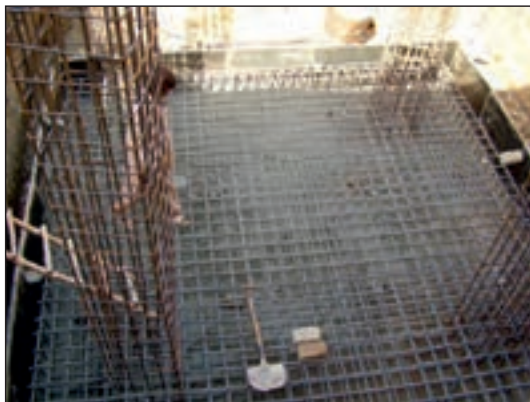
شکل ۱۵۱-۲ آرماتورگذاری پی صفحه‌ای با ستون‌های بتنی
