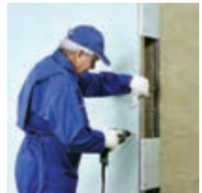
اجرای پانل‌ها در طرف دیگر دیوار
