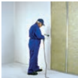
اجرای پانل‌ها در دو طرف دیوار
