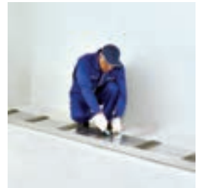
برش نوارهای عایق
