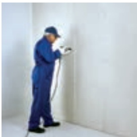
اجرای لایهٔ دوم پانل‌ها
