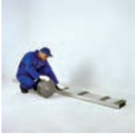
اجرای نوار عایق بر روی استاداها
