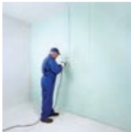
اجرای لایه دوم پانل ها
