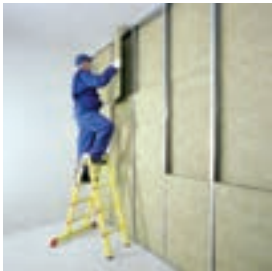
اجرای عایق پشم معدنی
