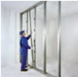
اجرای ردیف دوم استاداها
