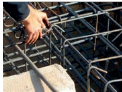
شکل ۲-۱۴۱ بستن خاموت دور آرماتور اصلی شناژ
