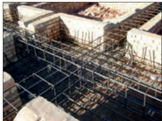
شکل ۷۱-۲ عبور میلگردهای شناژ در پی
