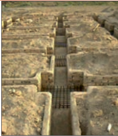
شکل ۴۸-۱ آرماتورگذاری پی تکی کلاف بندی شده
