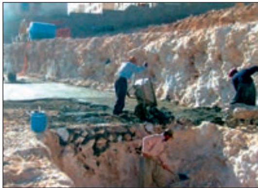
شکل ۸۷-۱ گودبرداری دستی (با بیل و کلنگ)
