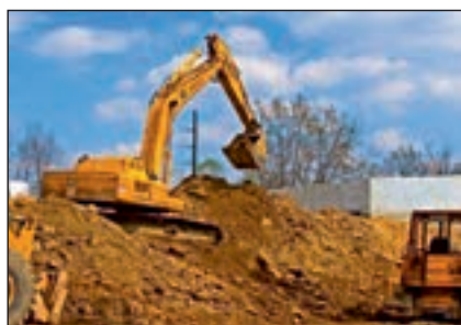
شکل ۱-۱۳- کندن زمین با وسایل مکانیکی
