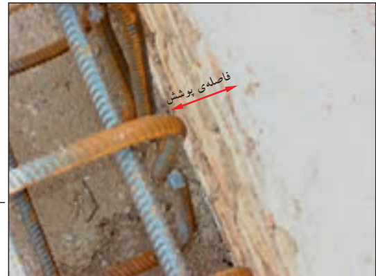
شکل ۲-۱۲۶ فاصله‌ی پوشش و قلاب سر میل‌گردها
