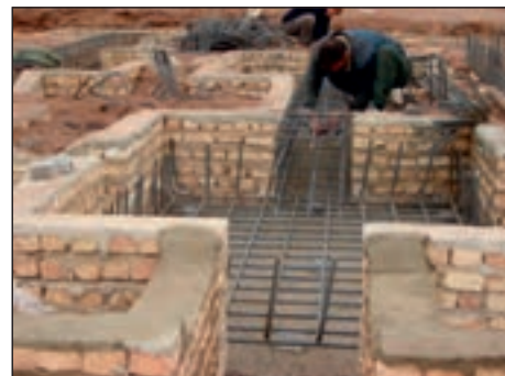
شکل ۱-۸۲ قالب‌بندی آجری در اطراف پی
