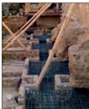
شکل ۹۰-۱ مهاربندی با شمع چوبی
