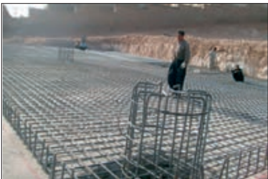
شکل ۱۵۲-۲ آرماتورگذاری پی صفحه‌ای با ستون‌های بتنی
