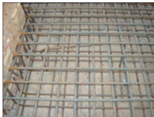
شکل ۱۴۷-۲ پی نواری و آرماتورگذاری آن
