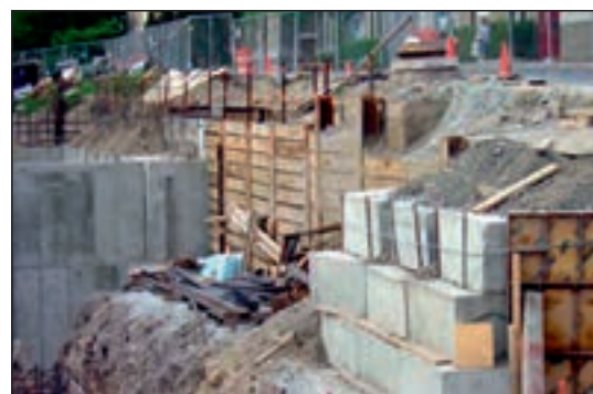
شکل ۹۱-۱ مهاربندی با دیوار مانع چوبی
