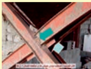
ضعیف بودن جوش و عدم اتصال مناسب
