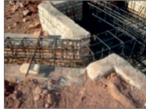
شکل ۲-۱۴۳ آرماتورهای شناژ و پی
