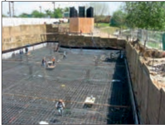
شکل ۱-۶۲ پی بتن مسلح یکپارچه (رادیه ژنرال)
