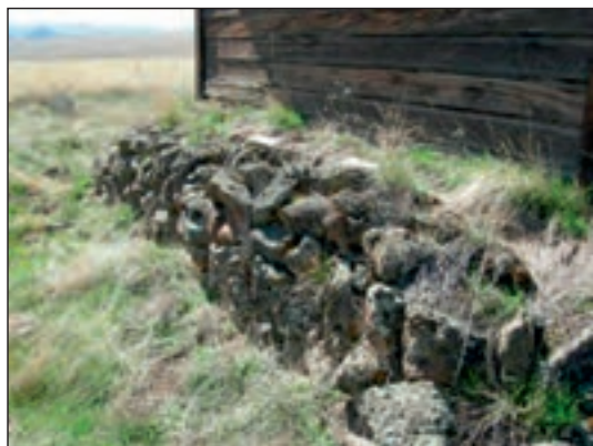
شکل ۱-۳۲ پی سنگی با سنگ لاشه
