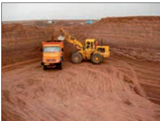
شکل ۸۵-۱ گودبرداری با لودر در زمین نامحدود
