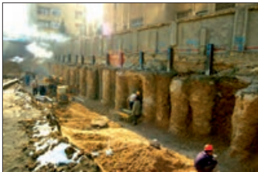
شکل ۸۸-۱ مهاربندی با پشت بند خاکی ستونی
