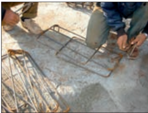
شکل ۲-۱۴۰ خم آرماتور و ساخت خاموت
