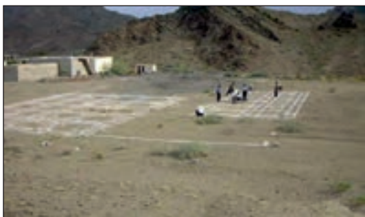
شکل ۸۳-۱ پیاده کردن نقشه روی زمین
