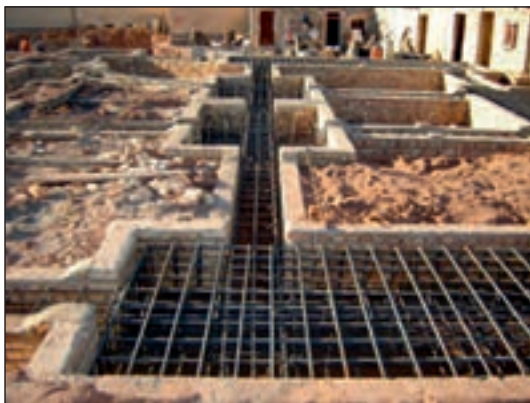
شکل ۷۰-۲ میلگردگذاری در پی کلاف بندی
