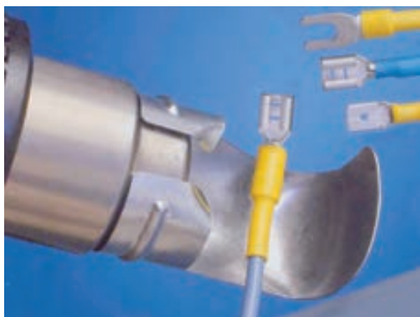
شکل ۷۹-۸- عایق کاری اتصال سرسیم به سیم
