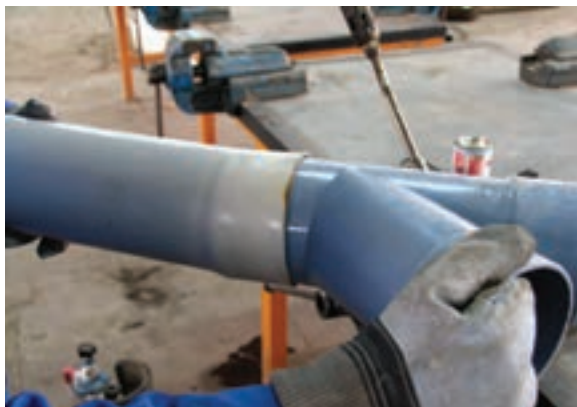
شکل ۲-۱۰- خارج کردن فیتینگ از سرکاسه
