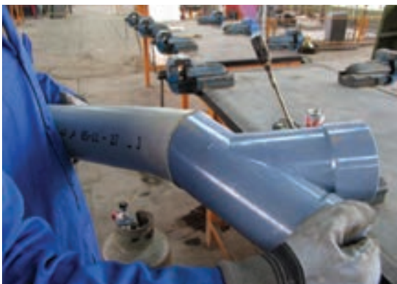
شکل ۲-۹- درست کردن سرکاسه
