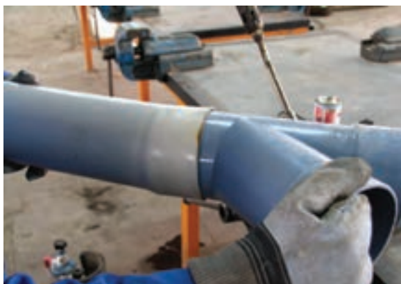
شکل ۲-۱۰- خارج کردن فیتینگ از سرکاسه
