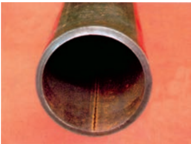
شکل ۲-۱۳- لوله‌ی برقو خورده
