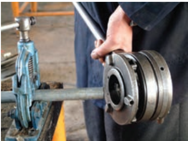
شکل ۴-۶۳- شروع حدیده کاری
