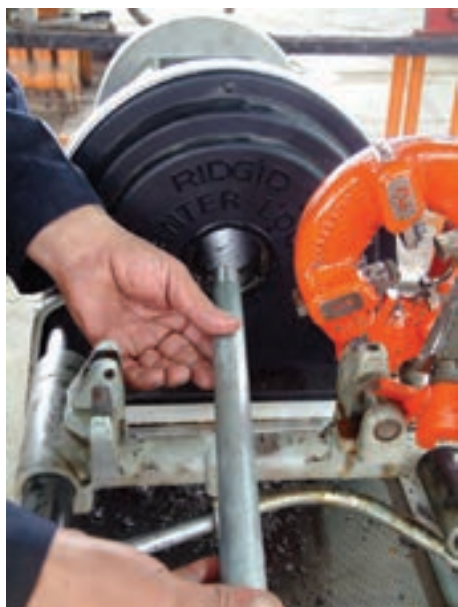
شکل ۴-۱۳۹- سر و ته کردن لوله در داخل سه نظام‌ها
