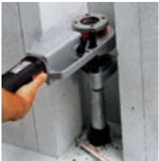
شکل ۴-۱۰۵ - طرز استفاده از حدیده
