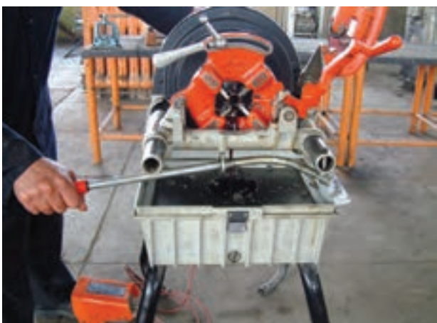
شکل ۱۳۳-۴ عمل حدیده کاری لوله
