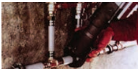
شکل ۲۳-۵ - اتصال پرسی
