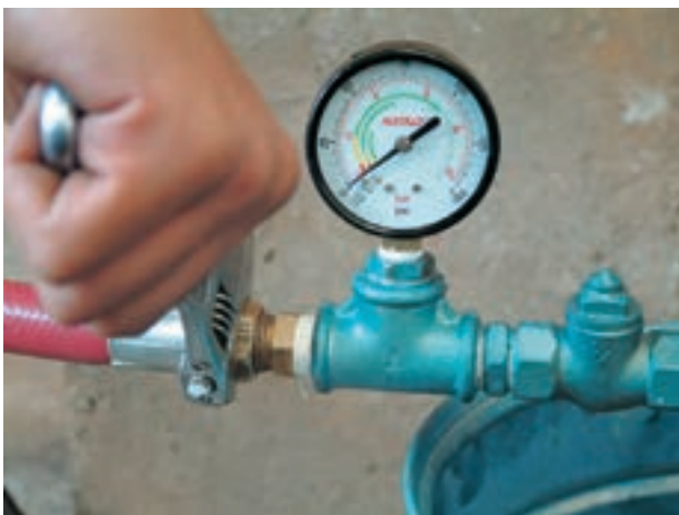
شکل ۵-۱۰۷- سفت کردن مهره‌ی شش‌گوش برنجی سرشیلنگی به وسیله‌ی آچار فرانسه
