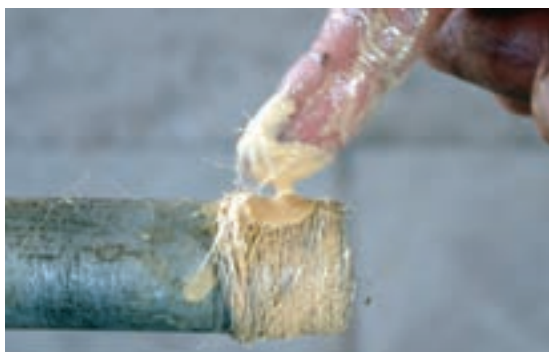
شکل ۱۵۲-۵- خمیر و کنف کردن سردنده‌ها
