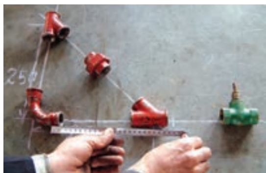
شکل ۱۳۴-۵- اندازه‌گیری لوله‌های مورد نیاز
