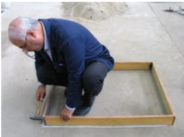
شکل ۴-۱- قالب‌بندی فونداسیون
