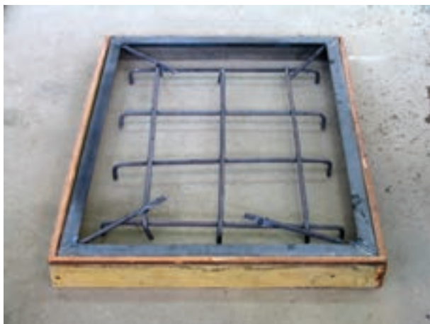
شکل ۵-۱- قرارگیری میل‌گردها در قالب
