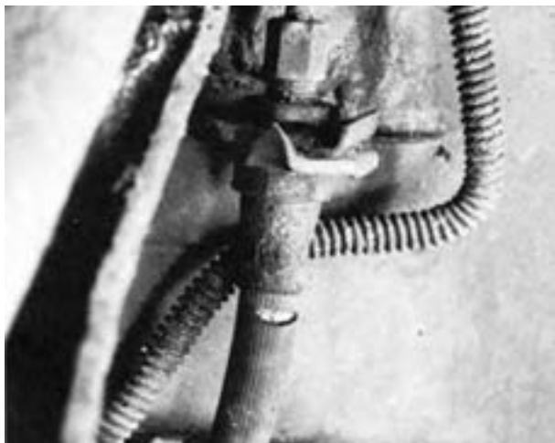
شکل ۱-۶۹- کنترل لوله‌ها و اتصالات
