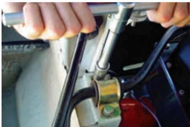
شکل ۳-۸۶- باز کردن میله ضد غلتش (موج گیر)
