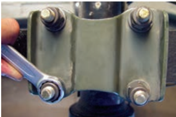
شکل ۳-۶۶- باز کردن مهره‌های کرپی‌ها (پیچ‌های U شکل)
