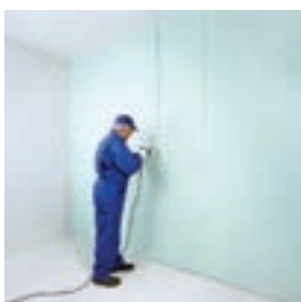
اجرای لایه دوم پانل‌ها
