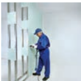
اجرای پانل‌ها در یک طرف دیوار
