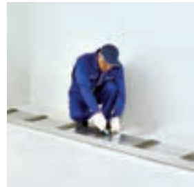
برش نوارهای عایق
