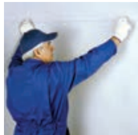
مشخص کردن محل نصب سازه تراز باربر با ریسمان رنگی
