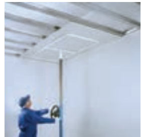
استقرار پانل با استفاده از بالابر
