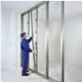
اجرای ردیف دوم استاداها
