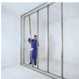
اجرای ردیف اول استاداها
