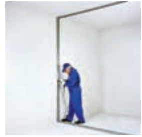
نصب استاد بر روی ساختار جانبی
