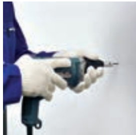
نحوه صحیح در دست گرفتن پیچ گوشتی برقی اجرای پانل‌ها در یک طرف دیوار
