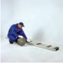
اجرای نوار عایق بر روی استاداها
