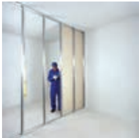
نحوه صحیح در دست گرفتن پیچ گوشتی برقی اجرای پانل‌ها در یک طرف دیوار
