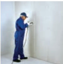
اجرای لایه دوم پانل‌ها
