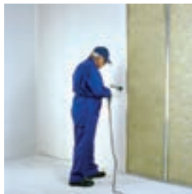
اجرای پانل‌ها در دو طرف دیوار
