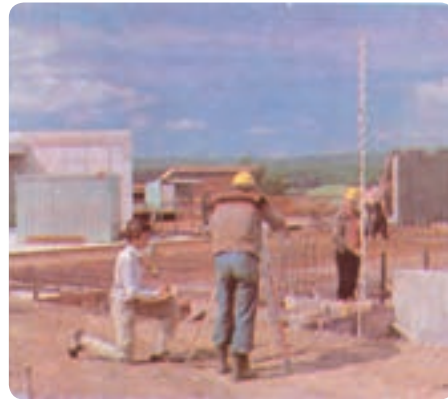
شکل ۱۴-۸- طریقه‌ی نگاه داشتن میر
