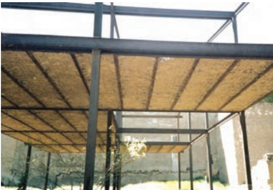
تصویر ۱۰ - تیرریزی سقف طاق ضربی
