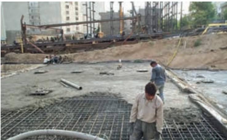
تصویر ۹ - عملیات بتن‌ریزی در محل کارگاه ساختمانی (پی گسترده)
