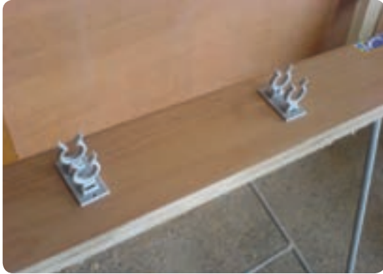
شکل ۶-۶۵ اتصال کلیپس پاسنگ به پایه کابینت
