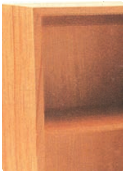
شکل ۶-۷ سقف و کف همرو با بدنه
