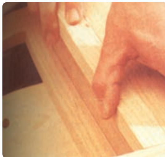
شکل ۶-۱۵۶ نصب ریل هدایت کشو
