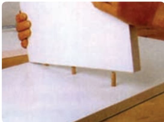
شکل ۶-۷۴ اتصال دوبل جهت مونتاژ کابینت
