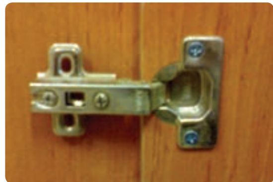
شکل ۶-۸۵ نصب کاسه لولا روی در کابینت
