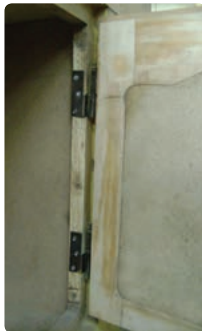
شکل ۶-۸۸ در قاب تنکه‌ای با لولای قابل‌مهم‌ای
