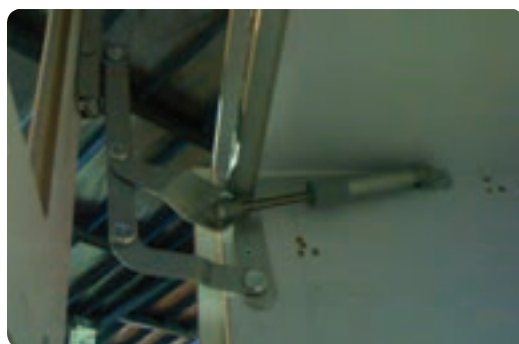
شکل ۶-۳۸ در کابینت نصب شده با جک اتوبوسی
