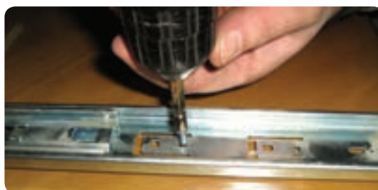
شکل ۷-۳۴ پیچ کردن ریل به بدنه فایل
