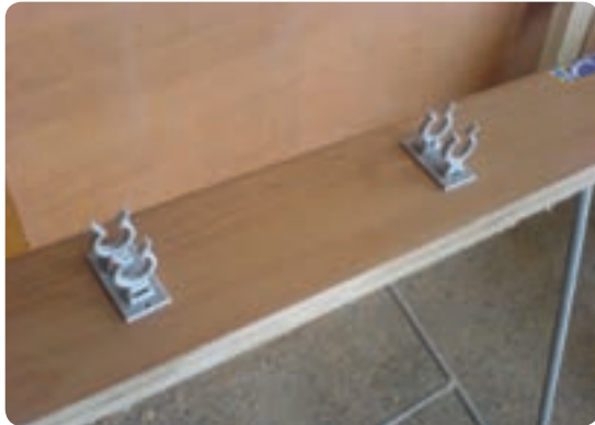
شکل ۶-۶۵ اتصال کلیپس پاسبنگ به پایه کابینت
