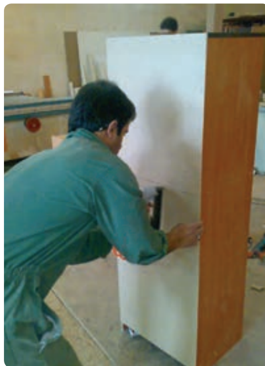
شکل ۱۲۱-۶ نصب پشت بند کابینت
