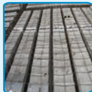
شکل ۲-۲۸- سقف تیرچه و بلوک
