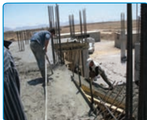
شکل ۴۲-۷- بتن ریزی دال پله
