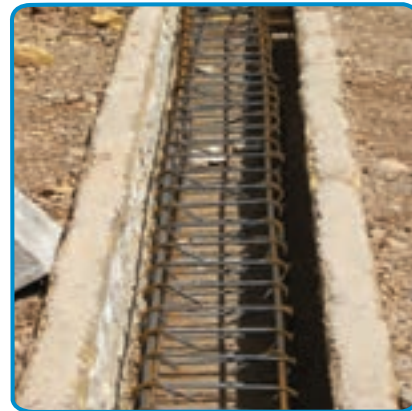
شکل ۵-۷- اجرای میلگرد شناژها
