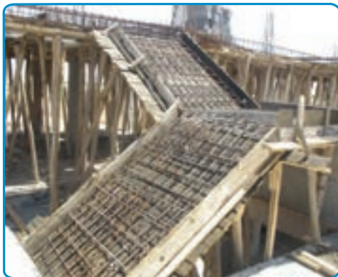
شکل ۳۹-۷- اجرای میلگردهای دال پله
