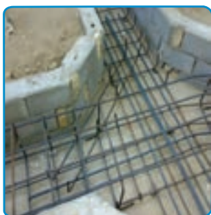
شکل ۱۳-۷ قرار دادن میلگردهای تقویتی پخها
