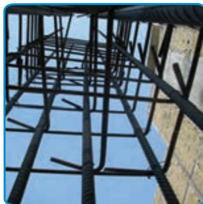
شکل ۱۹-۷- کار گذاشتن میلگردهای انتظار ستون، در فونداسیون
