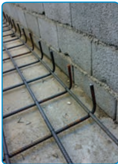
شکل ۱۰-۷- رعایت پوشش بتن در کف و بدنه
