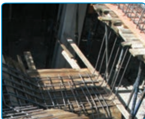
شکل ۴۱-۷- اجرای میلگردهای دال پله
