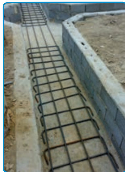
شکل ۸-۷- چیندن میلگردهای طولی و عرضی
