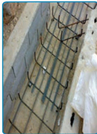
شکل ۱۱-۷- قرار دادن میلگردهای تقویتی
