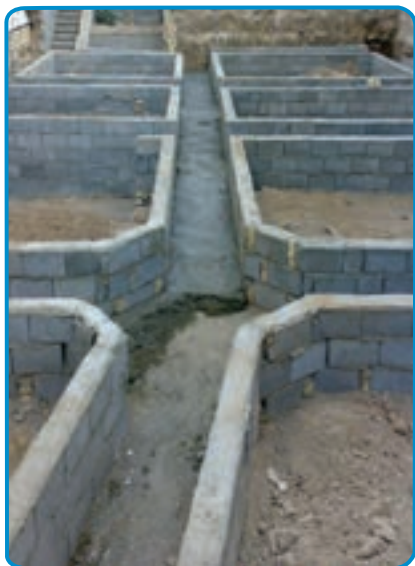
شکل ۶-۷- آماده سازی کف پی
