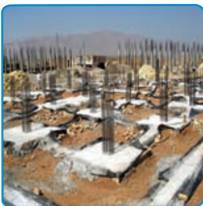
شکل ۱۷-۷- اجرای خاموت و سنجاقک
