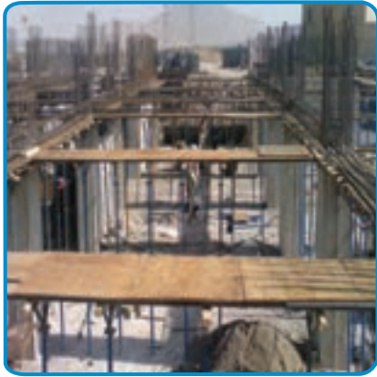
شکل ۷-۲۱- قالب بندی تیرها
