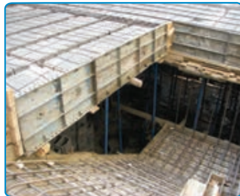
شکل ۴۰-۷- اجرای میلگردهای دال پله
