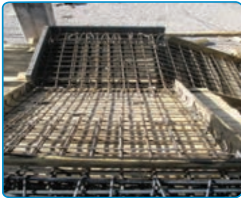
شکل ۳۷-۷- اجرای میلگردهای دال پله
