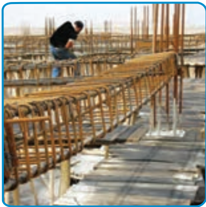
شکل ۷-۲۴- تنظیم فاصله بین خاموت ها
