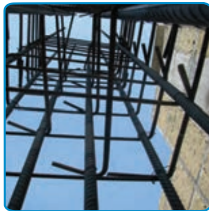
شکل ۱۹-۷- کار گذاشتن میلگردهای انتظار ستون، در فونداسیون
