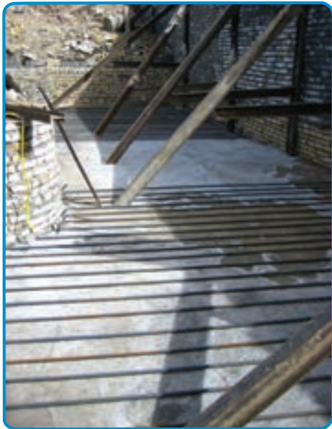
شکل ۳-۴۶- میلگرد طولی کف پی
