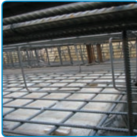
شکل ۳-۵۳ - استفاده از خرک در میلگرد گذاری پی
