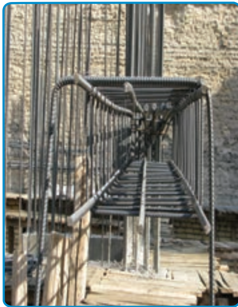
شکل ۳-۴۵- میلگرد طولی در تیر
