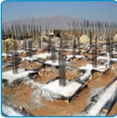
شکل ۱۷-۷- اجرای خاموت و سنجاقک
