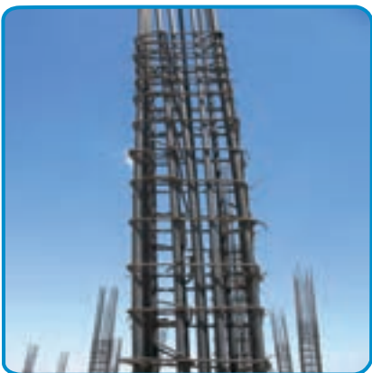
شکل ۱۹-۷- کار گذاشتن میلگردهای انتظار ستون، در فونداسیون
