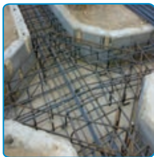
شکل ۱۴-۷ تکمیل میلگردگذاری محل اتصال ستون
