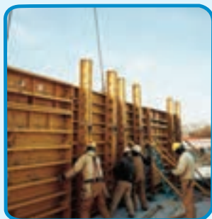
شکل ۳-۳۶- قالب فایبر گلاس برای اجرای دیوار بتنی
