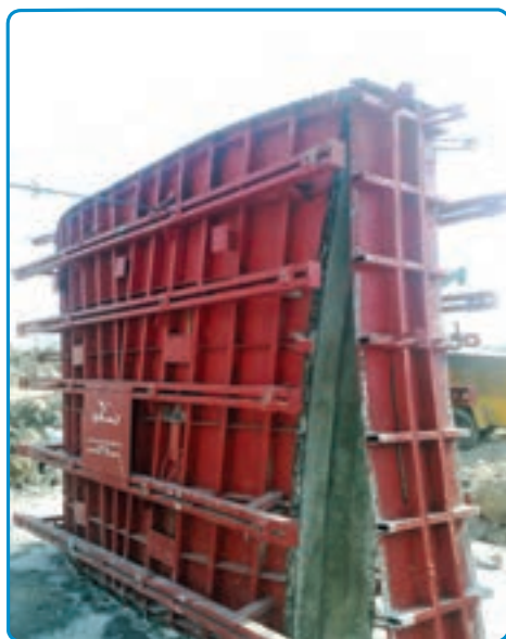
شکل ۳-۴۲- قالب برداری
