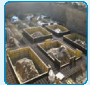
شکل ۳-۳۱- قالب فایبرگلاس برای اجرای پی
