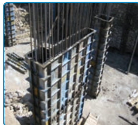
شکل ۳-۳۵- قالب فلزی برای اجرای دیوار بتنی
