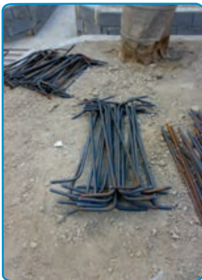
شکل ۷-۷- آماده کردن میلگردهای طولی و عرضی
