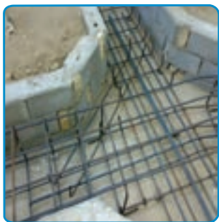
شکل ۱۳-۷ قرار دادن میلگردهای تقویتی پخها
