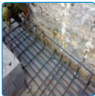
شکل ۱۲-۷ میلگردگذاری شبکه بالای
