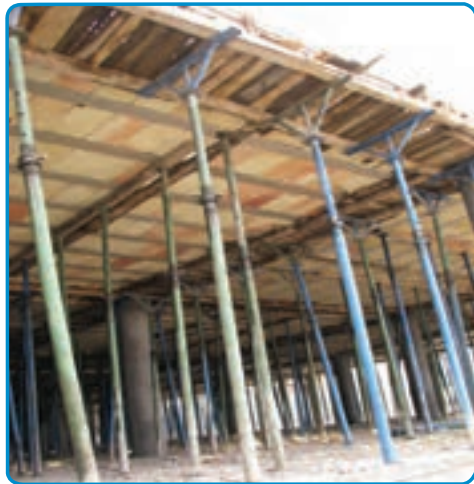
شکل ۳-۲۱- استفاده از شمع‌های فلزی جهت نگهداری قالب‌ها
