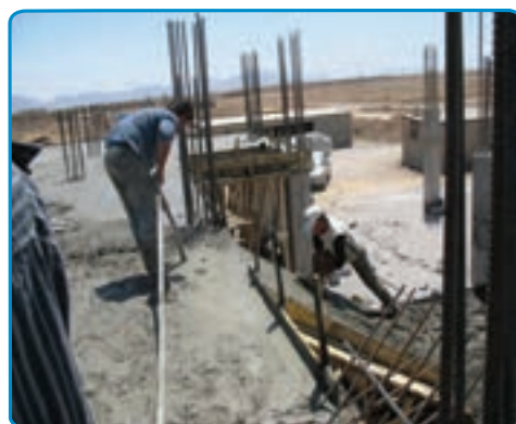
شکل ۴۲-۷- بتن ریزی دال پله
