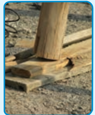
شکل ۳-۲۵- استفاده از گوه جهت تنظیم ارتفاع
