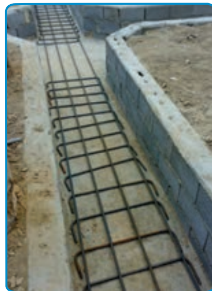
شکل ۸-۷- چیندن میلگردهای طولی و عرضی
