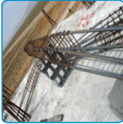
شکل ۷-۲۲- آماده کردن میلگردهای تیر روی زمین
