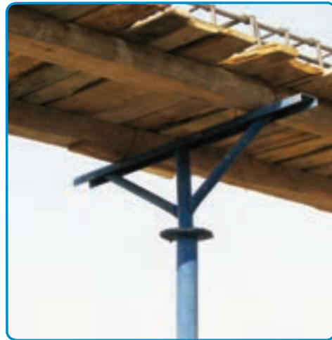
شکل ۳-۲۱- استفاده از شمع‌های فلزی جهت نگهداری قالب‌ها
