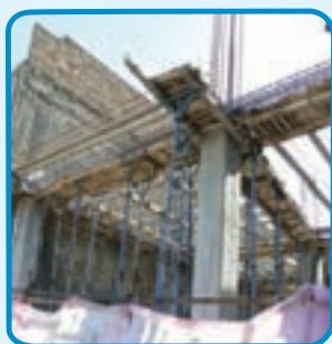
شکل ۳-۳۹- استفاده از قالب چوبی برای اجرای تیر
