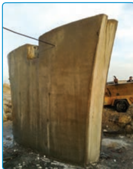
شکل ۳-۴۲- قالب برداری
