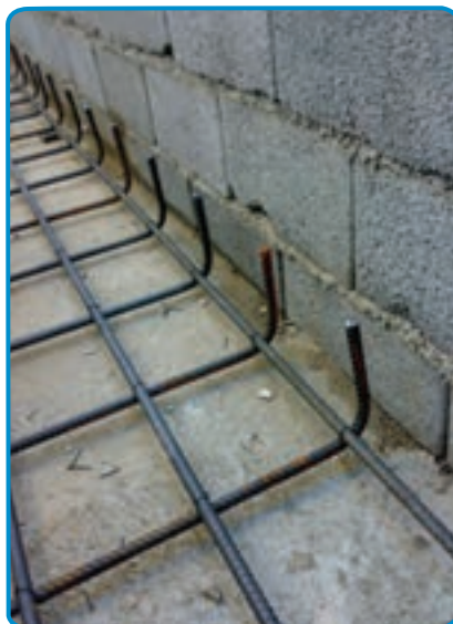
شکل ۱۰-۷- رعایت پوشش بتن در کف و بدنه
