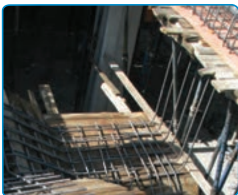
شکل ۴۱-۷- اجرای میلگردهای دال پله
