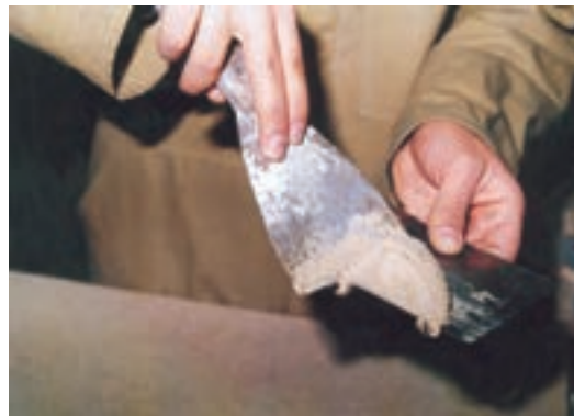
شکل ۴-۸- کاربرد لیسه و کاردک هنگام بتونه کاری.
