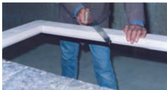
شکل ۱۱-۲۶- ایجاد شیار با اره‌ی دستی.
