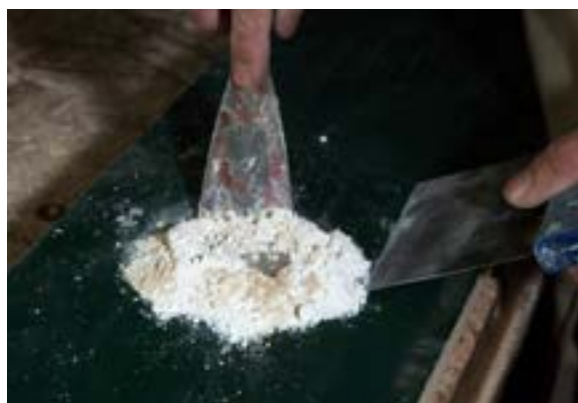
شکل ۴-۱۴- پگه‌نگی کار کردن با کاردک و لیسه.
