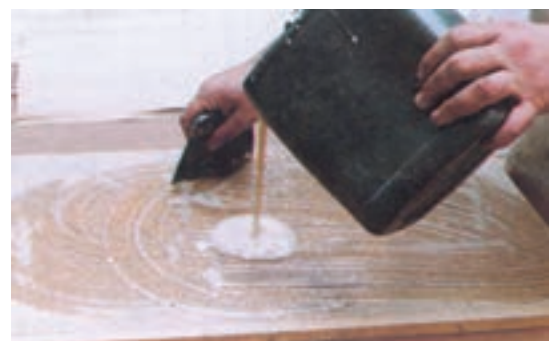
شکل ۴-۶. پفش کردن چسب به وسیله‌ی شانه‌ی چسب‌زنی.
