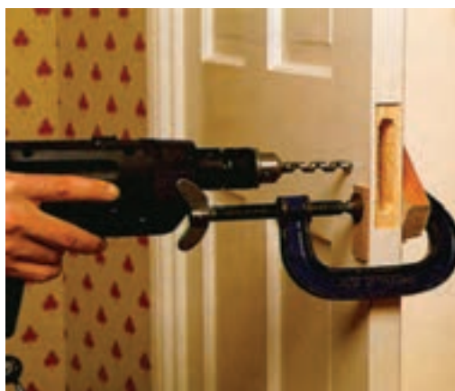
شکل ۱۰-۴۸- سوراخ‌کاری ممل پلاک و دستگیره‌ی قفل.
