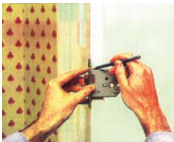
شکل ۱۰-۴۴ - فم‌کشی ممل قفل (روی نرِ کار).
