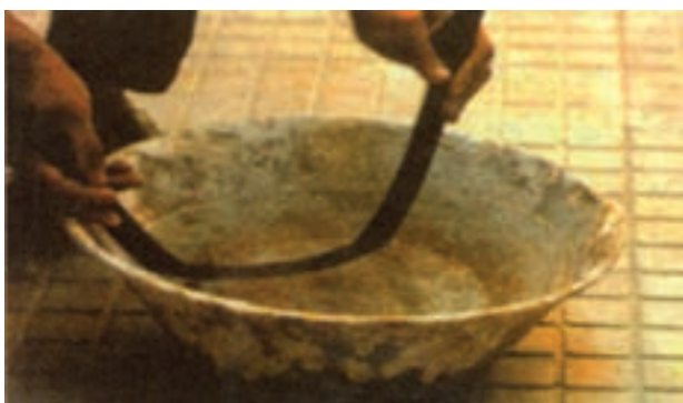
شکل ۴-۴۵- سرد کردن لوله پس از خم‌کاری
