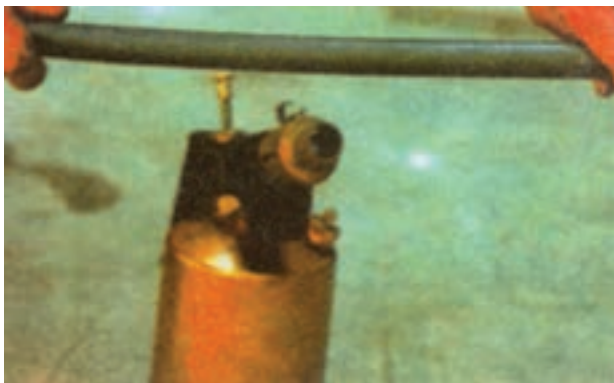
شکل ۴-۴۳- حرارت دادن لوله‌ی PVC
