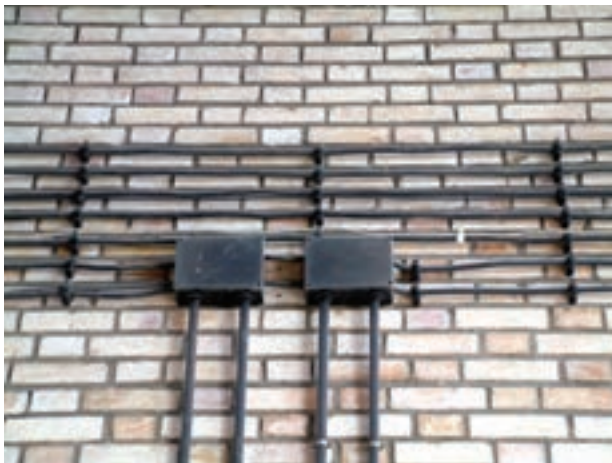
شکل ۵-۵۷- کابل‌کشی روی دیوار
