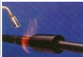
ب- طریقه‌ی حرارت دادن روکش الف- انواع روکش حرارتی
