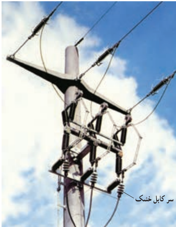
شکل ۶-۶- سر کابل خشک حرارتی هوایی
