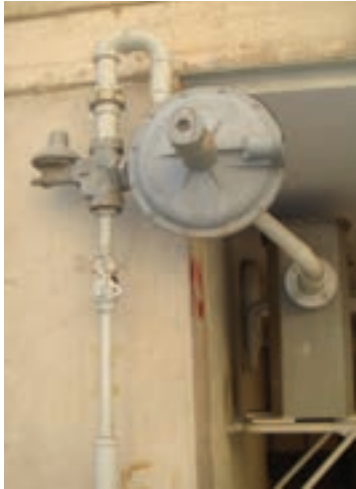
▲ شکل ۲-۹۳ علمک و رگولاتور روی آن
