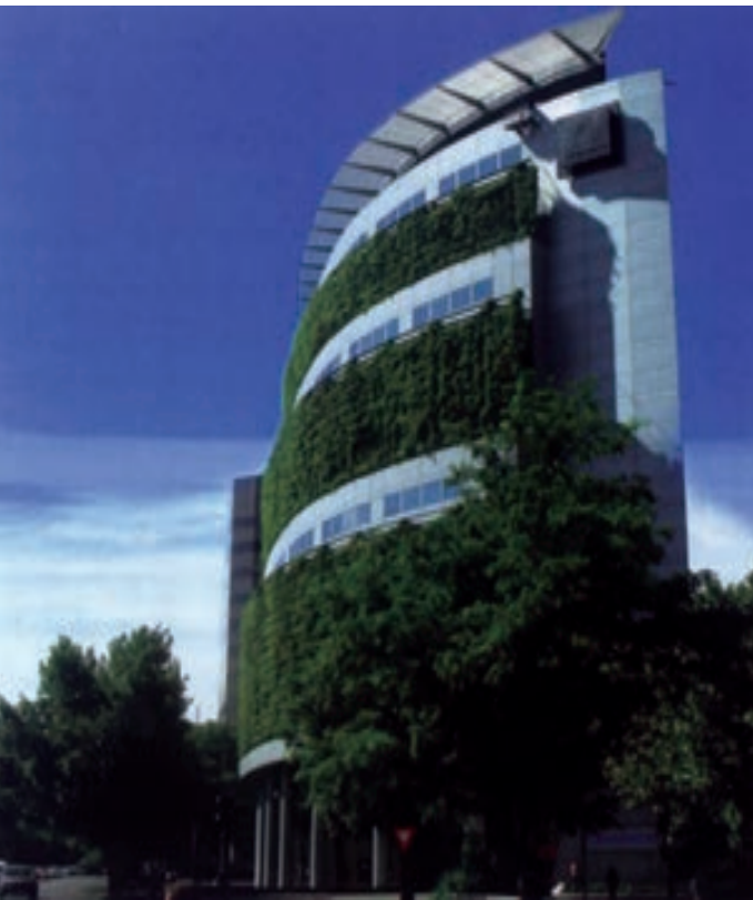
تصویر ۲۷-۵- استفاده از پوشش گیاهی در بدنه خارجی ساختمان
