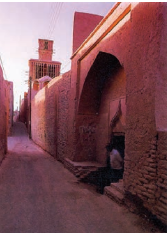
تصویر ۹-۵- نمای بیرونی فاقد پنجره
