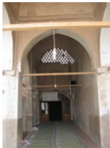
▲ شکل ۴-۷۲ کاربرد چوب در ساخت قوس‌ها
