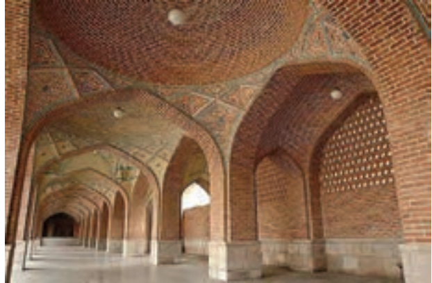
▲ شکل ۴-۶۸ قوس های آجری (مسجد کبود تبریز)
