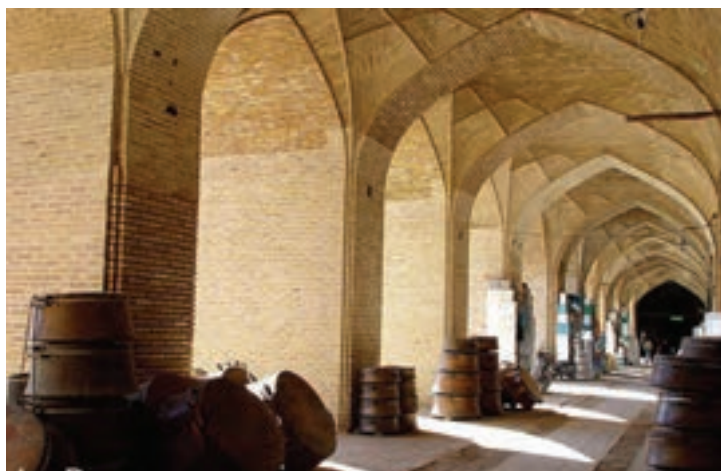
شکل ۳۹-۴ قوس تیز با ارتفاع متوسط (بازار مسگرها در کرمان)
