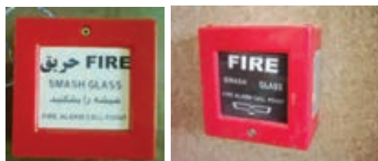
شکل ۱-۲۱ دو نمونه شستی اعلام حریق شیشه‌ای
