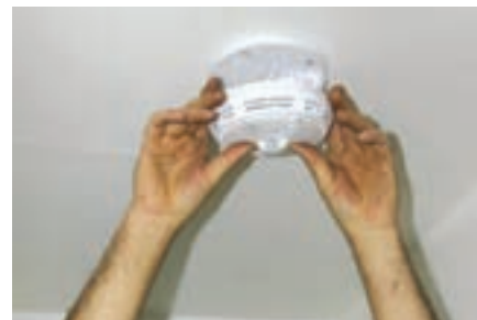
شکل ۱-۱۵ قرار دادن یک نوع آشکارساز روی پایه
